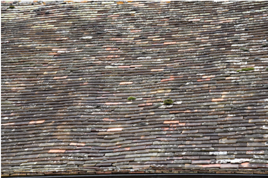
Remplacement des tuiles cassées avec des neuves plus oranges.
