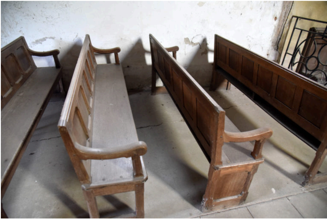
Fissures des dallages latéraux sur la longueur de la chapelle.
