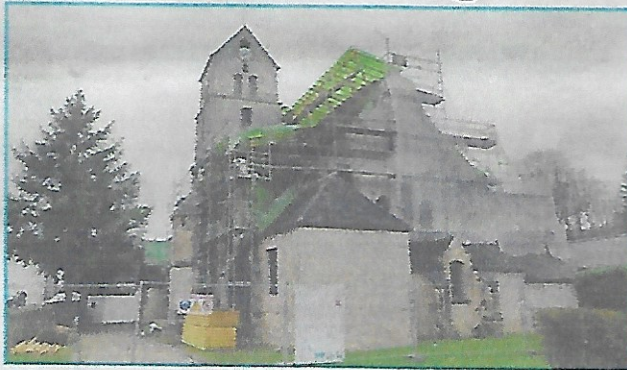
Le chantier en cours sur l'église Notre-Dame en sa Nativité.
